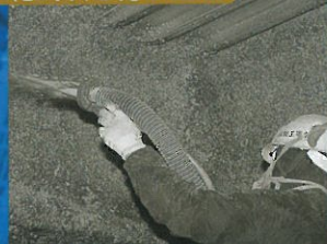
乾式吹き付け工法
