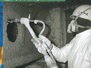
湿式吹き付け工法
